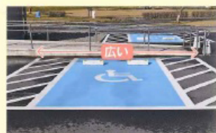
障害者用駐車スペース 車いす使用者が自動車で乗り降りしやすいように、幅が広がっている。
